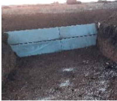
Окоп для БМП (БТР) з укриттям екіпажу (УТ-1)
